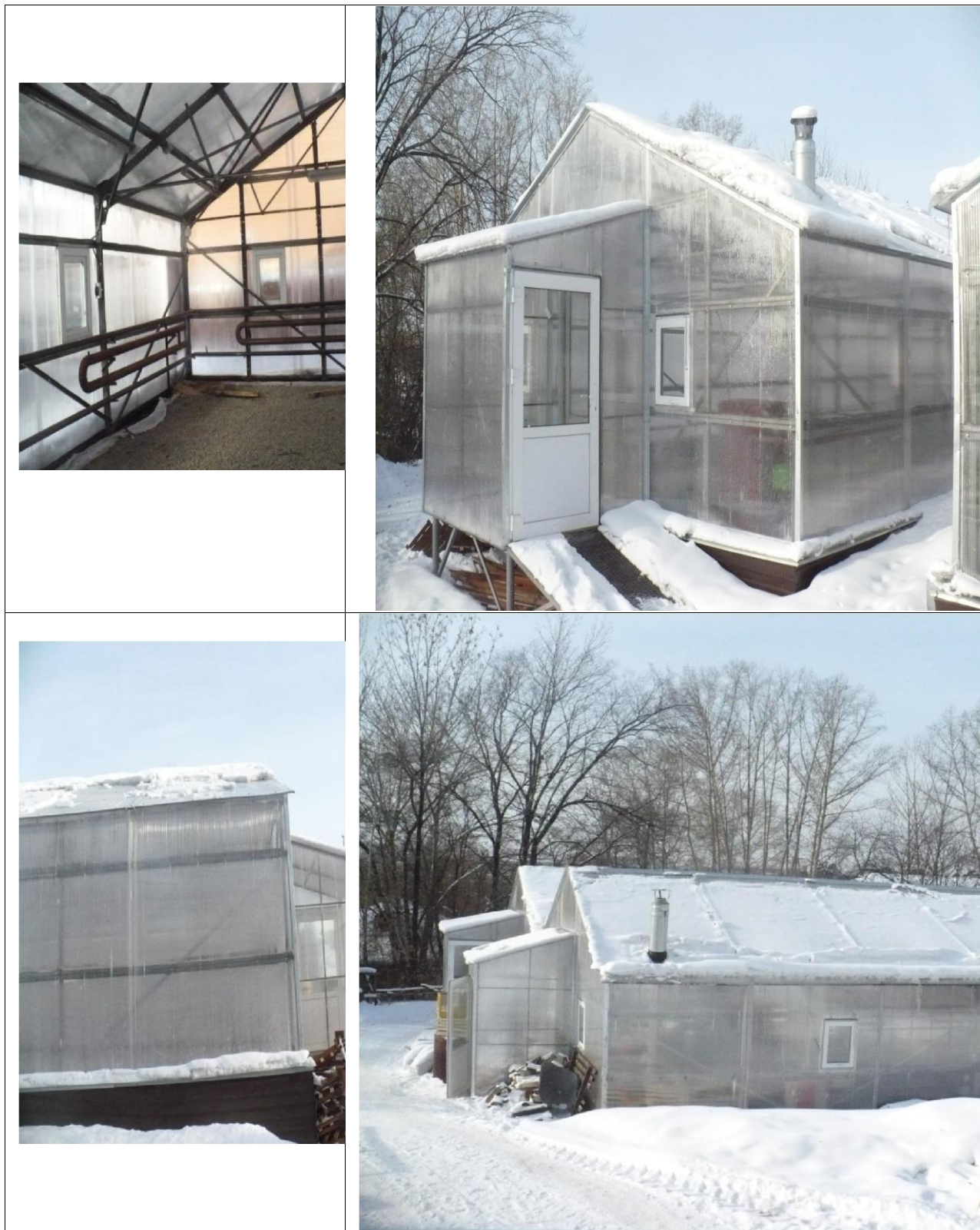
Рис. 2. Реконструированные производственные теплицы на территории агробиостанции Ботанического сада биолого-почвенного факультета ИГУ
